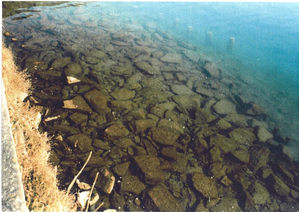
**Foto 7:** Die Uferbank besteht praktisch nur noch aus geschütteten Blöcken, das Interstitial der dazwischenliegenden Kiesel ist durch den Wellenschutz der Blöcke mit Feinstoffen und Sand aufgefüllt. Ein solcher Seegrund wird als grossflächig ungeeignet bezeichnet. Ein solcher Uferabschnitt würde sich, z.B. im Rahmen von Ersatzmassnahmen, zur Sanierung (Schüttung von geeignetem Kies) anbieten.
